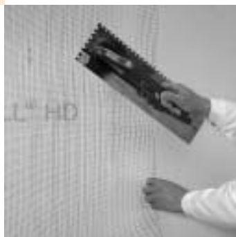
Figure 3.20 : Chevauchement du treillis de renforcement sur env. 10 cm
