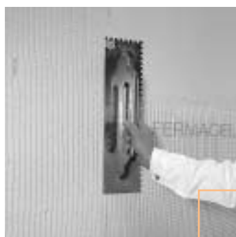
Figure 3.19 : Pression du treillis de renforcement FERMACELL HD dans le lit de mortier
