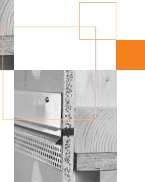
Figure 4.14 : Profilés de joint d'étage
