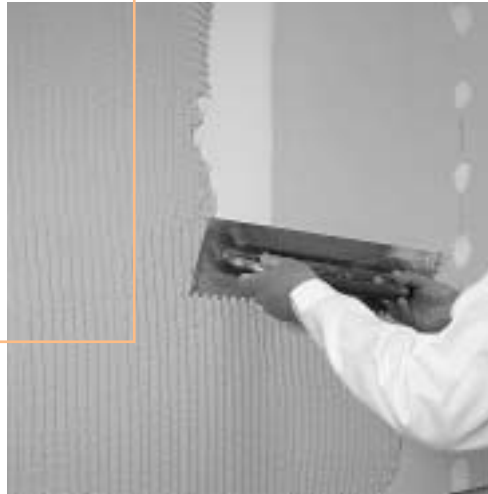
Figure 3.16 : Application du mortier léger FERMACELL HD
