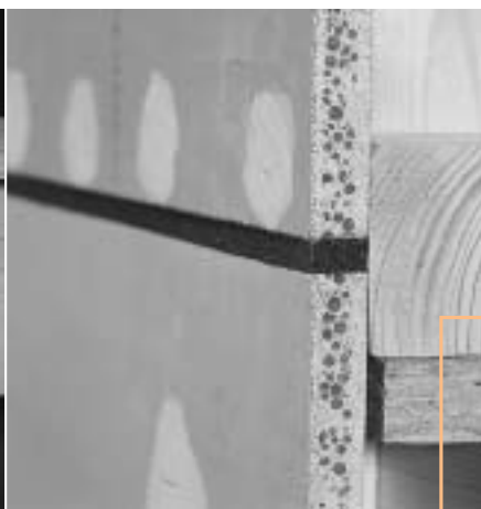
Figure 4.13 : Bande d'étanchéité précomprimée pour une protection provisoire contre les intempéries
