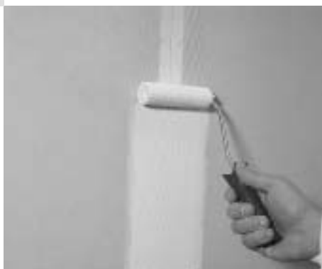
Figure 3.14 : Application de la colle de renforcement FERMACELL HD au rouleau
