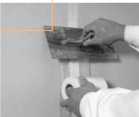
Figure 3.13 : Pose de la bande de renforcement FERMACELL HD
