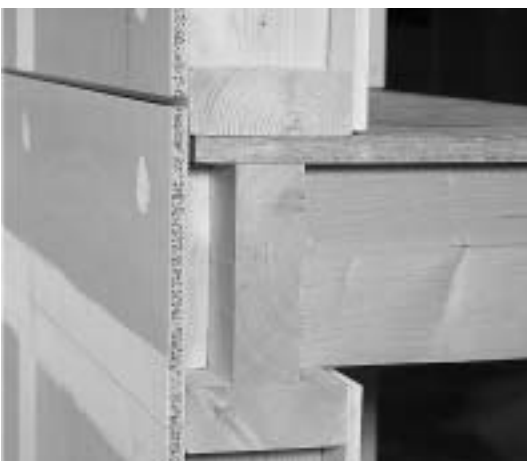
Figure 4.12 : Zone pourvue d'une bande de plaque avec la technique de jointolement HD
