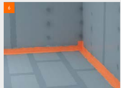
6 Dans le cas de plaques fermacell® Powerpanel sol TE, le SPEC est uniquement appliqué en angles
