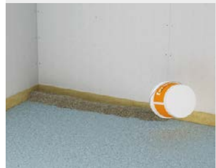
La première « digue » est dressée et nivelée
