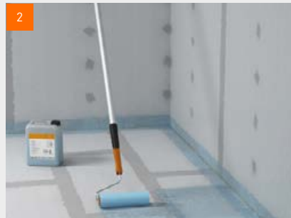
2 ... et application en pleine surface au rouleau
