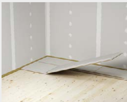
Recouvrir la battue à l'aide de la seconde plaque afin d'obtenir un collage parfait
