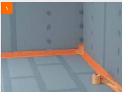
4 Marouflage de la bande de pontage dans la première couche de SPEC encore fraîche
