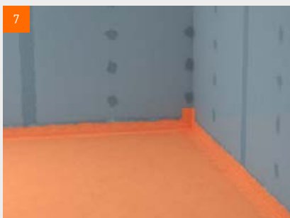
7 Dans le cas de plaques de sol fermacell®, les angles, mais également la totalité de la surface de la chape doit recevoir un SPEC
