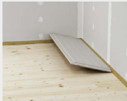
Poser les plaques de sol fermacell® en flottant sur le sol support
