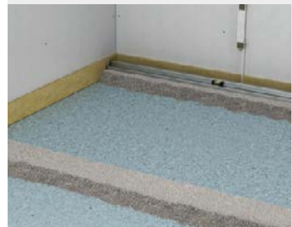
La seconde « digue » est égalisée à une hauteur semblable à la première
