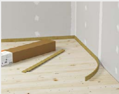
Placer la bande résiliente périphérique le long des murs
