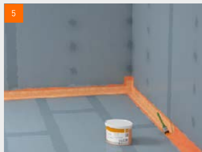
5 Puis passe de la seconde couche de SPEC sur la bande de pontage
