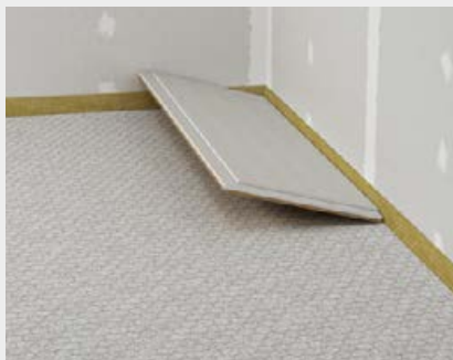
Recouvrir par les plaques de sol fermacell®
