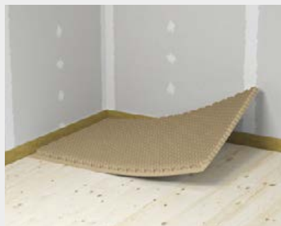
Pose des éléments nid d'abeilles au sol
