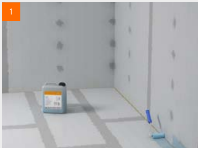
1 Application du primaire en périphérie de la chape ...
