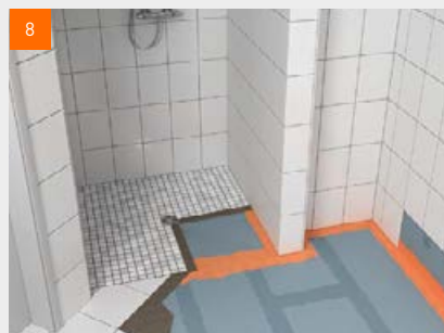
8 Les bandes de pontage servent également à traiter le raccord entre des plaques de sol fermacell® ou fermacell® Powerpanel sol TE et le receveur de douche à l'italienne fermacell® Powerpanel sol TE
