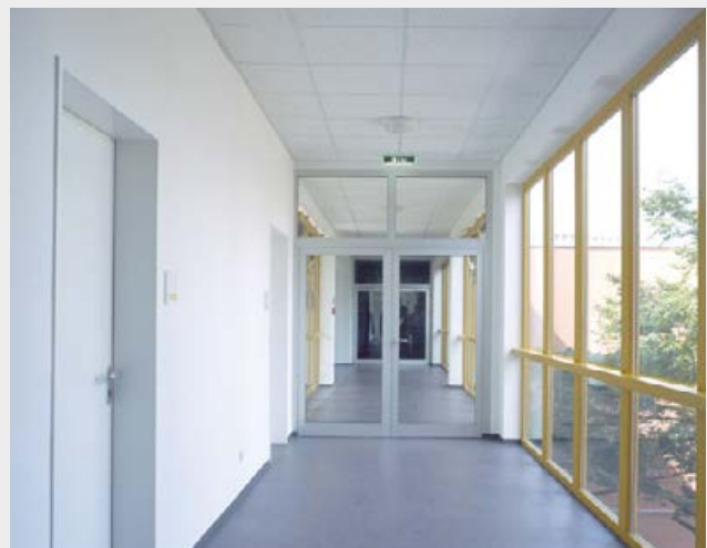
Corridors dans bâtiments administratifs et cabinets médicaux
