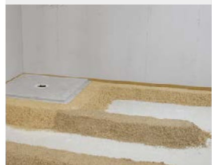
Attendre que le mortier d'égalisation formant les « digues » ait tiré (env. 20 minutes)
