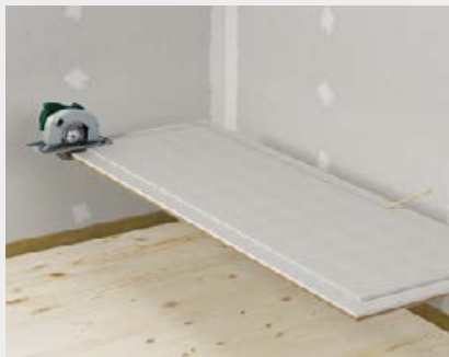
Découper les battues supérieures des plaques formant la première rangée
