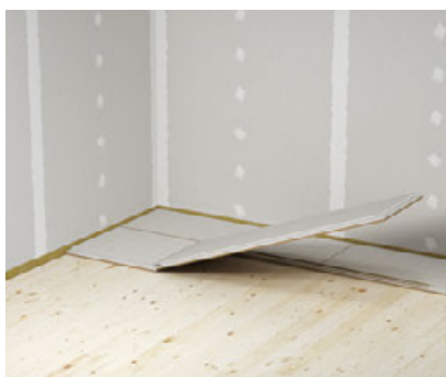
5 Recouvrir la battue à l'aide de la seconde plaque afin d'obtenir un collage parfait
