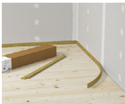
1 Placer la bande résiliente périphérique le long des murs
